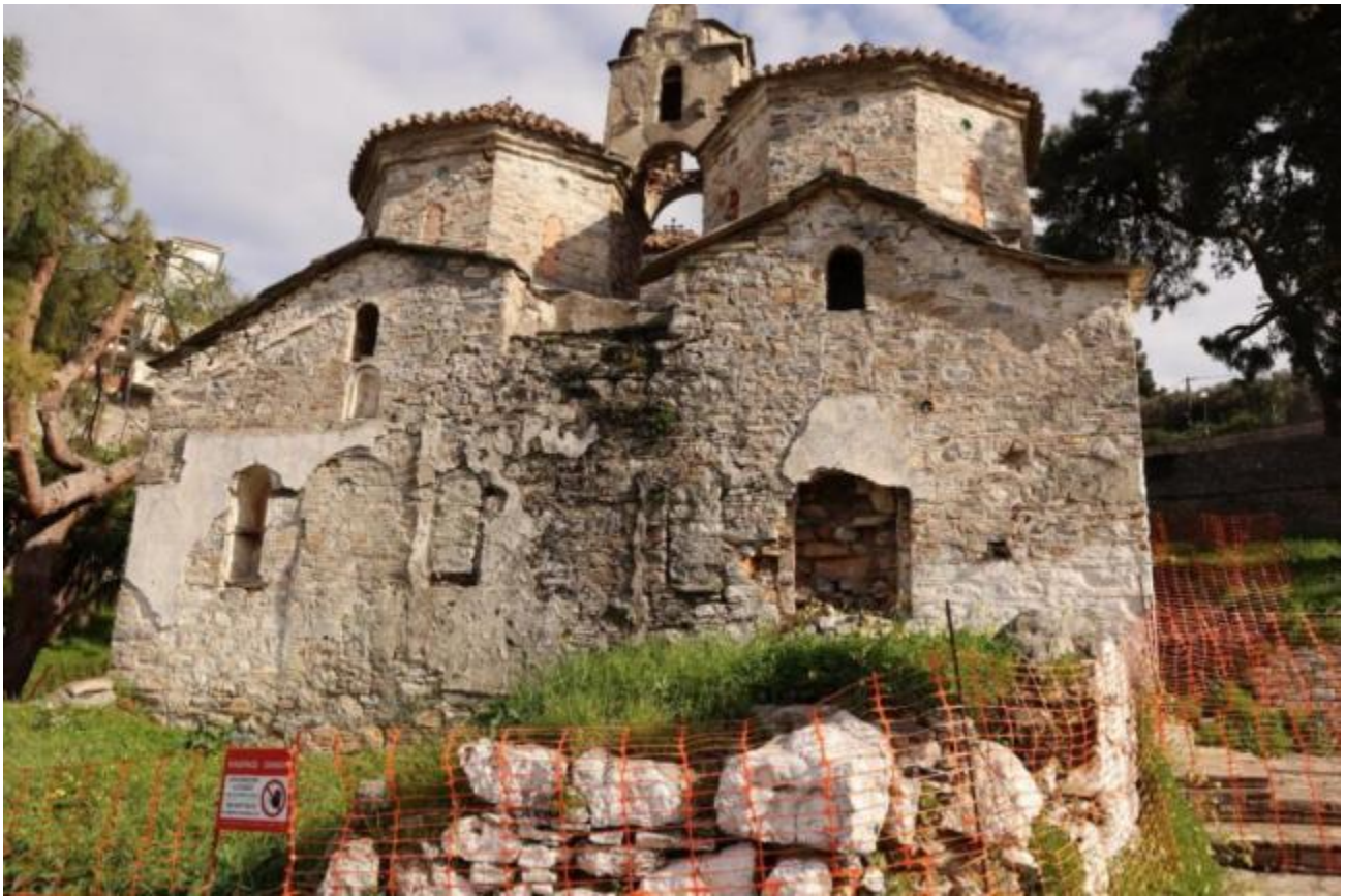
Εικόνα 07: Δυτική όψη του ναού πριν την έναρξη των εργασιών.
