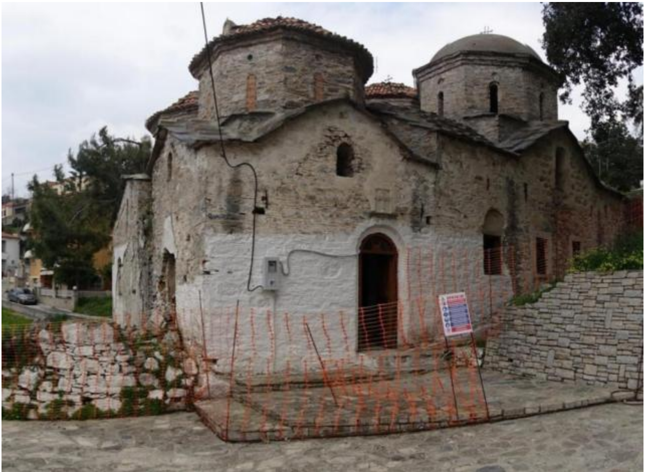
Εικόνα 05: Νοτιοδυτική όψη του ναού πριν την έναρξη των εργασιών.
