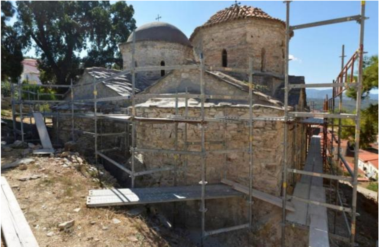
Εικόνα 09: Ανατολική όψη του ναού μετά την έναρξη των εργασιών.
